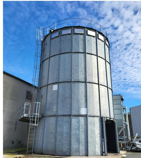
**Photos 4 : Chaufferie + silo à copeaux**
